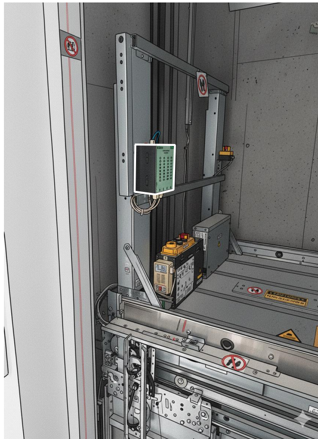
Figura 1. Equipo de control de accesos PROXEM BLUETOOTH instalado en el techo de la cabina del ascensor.
